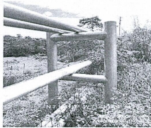
Fotografía 4. Estructuras de apoyo Marcos tipo H. Fuente: CAS-2022.
